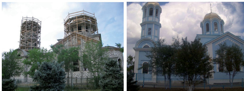
Строительство храма в Чадыр-Лунге
